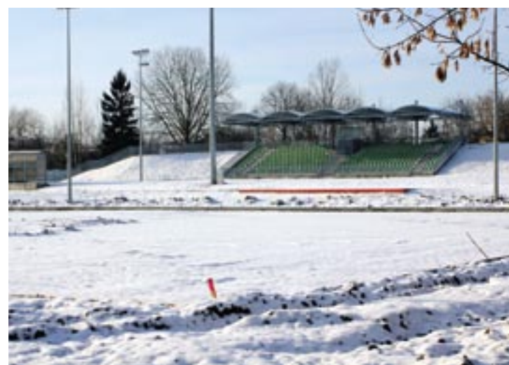
Na nowobudowanym boisku przy stadionie miejskim w Serocku trwają prace przy podbudowie z tłuczni pod nawierzchnię z trawy syntetycznej.
