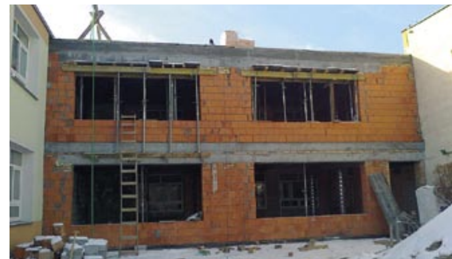
Na obiekcie szkoły w Woli Kiełpińskiej trwają prace przy wykonaniu więzby dachowej.
