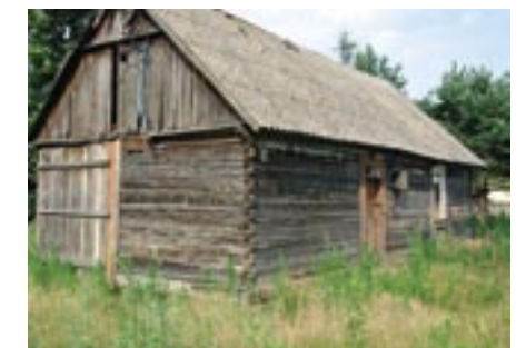
Stary dom pp Pawlaków przy ul. Nadbużańskiej
