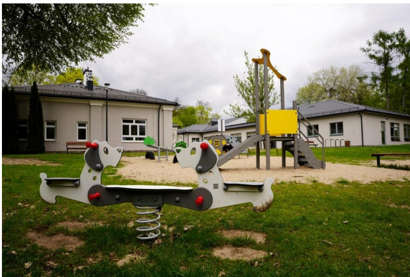
Fot. 2 Utworzenie oddziałów żłobkowych i budowa przedszkola w Zegrzu
