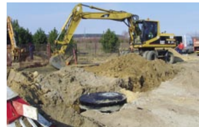
Budowa sieci kanalizacji sanitarnej na ul. Traugutta w Serocku
