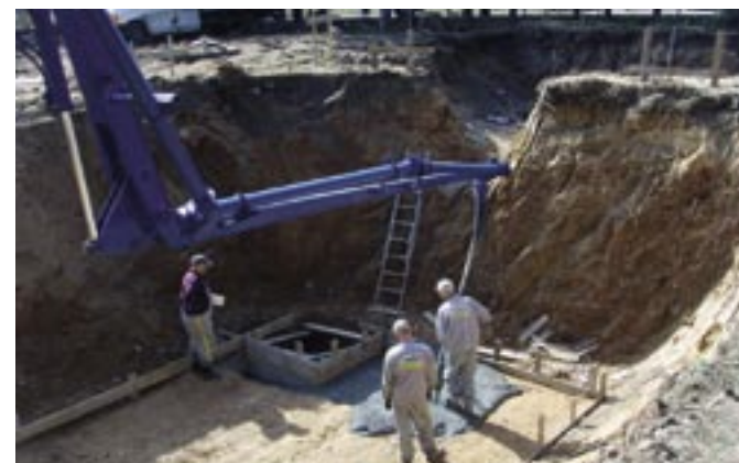
Prace przy stacji uzdatniania wody w Wierzbicy
