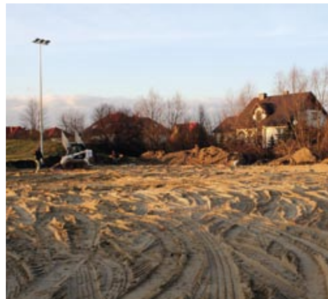
Budowa boiska przy stadionie miejskim w Serocku
