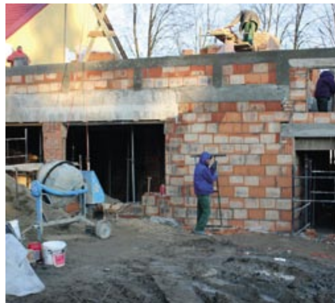
Rozbudowa Ośrodka Kultury w Serocku
